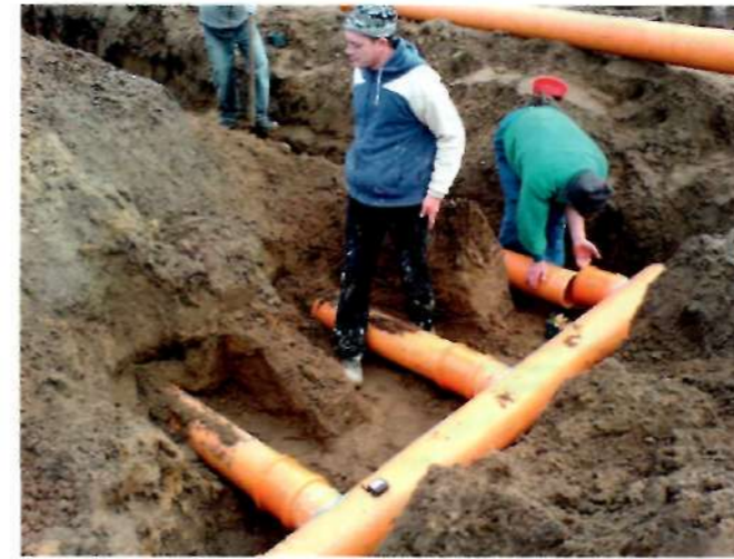
Passzívház talajkollektorának építése. Gödöllő, Boncsok-dűlő
