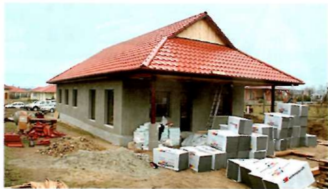
Az elkészült tetőhéjazat
