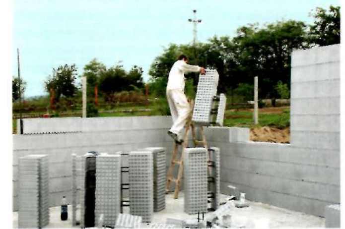
A falszerkezet építése
