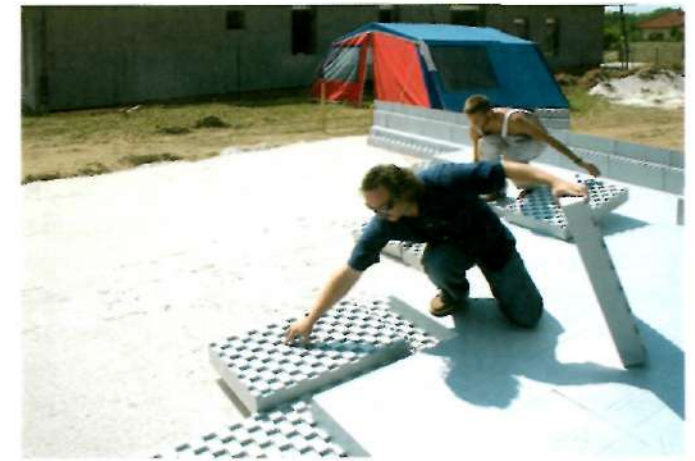
A lemezalap hőszigetelésének fektetése
